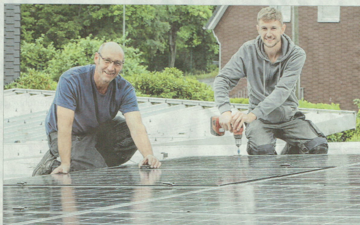
Haben die Photovoltaikanlage auf den Blechdach montiert: Dietmar Hofmayer (l.) und Daniel Reinschmidt.
